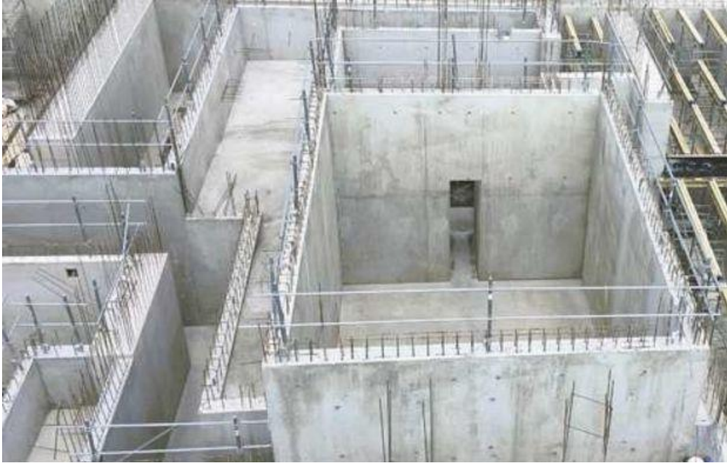
Les voiles de béton, qui montent jusqu'à 5 m, permettent de former des murs d'une épaisseur d'au moins 1 m. - © ZWICKERT
